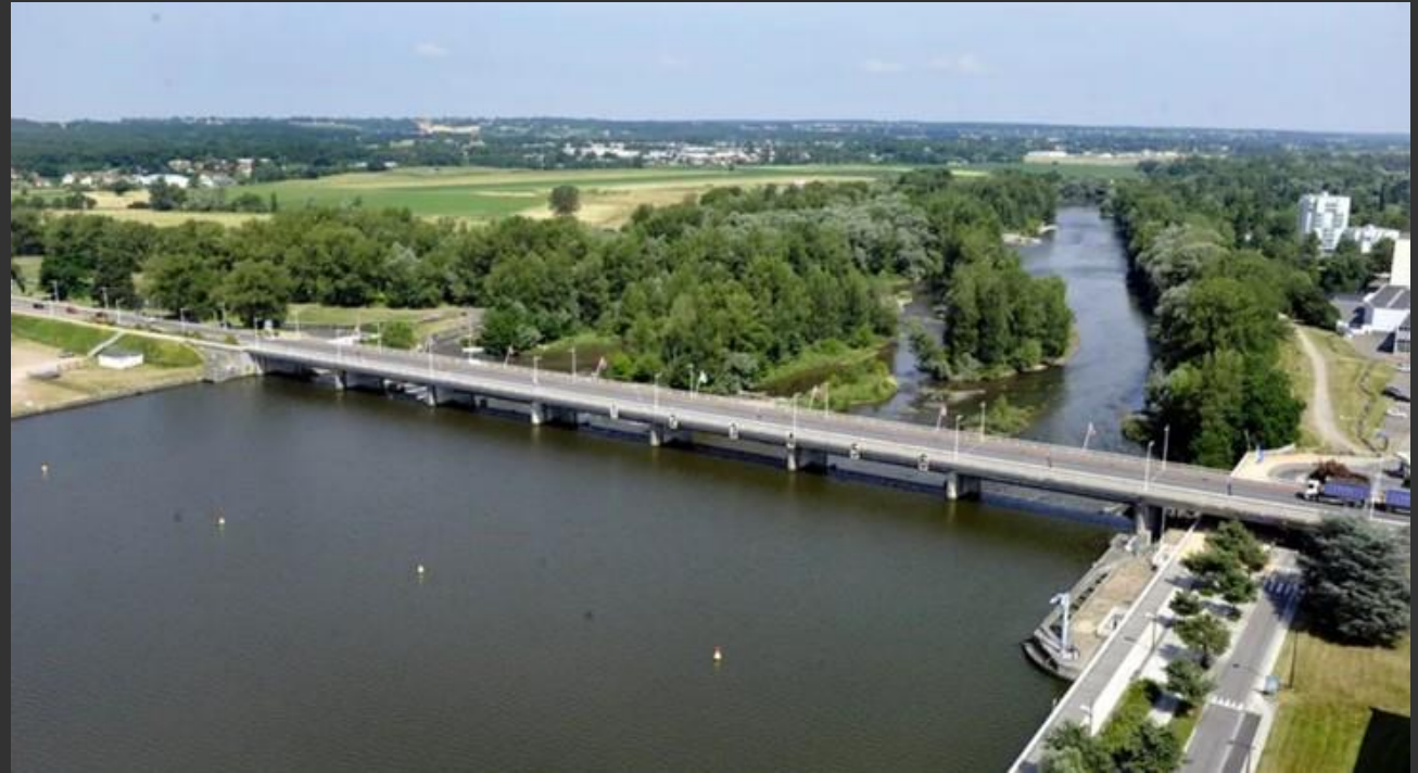
Vue amont du barrage de Vichy
