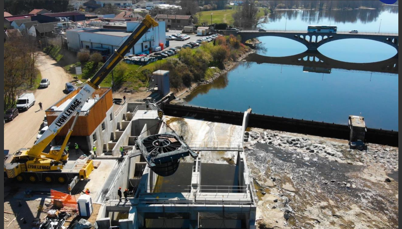
Pose des turbines VLH (source phot : SHEMA)
